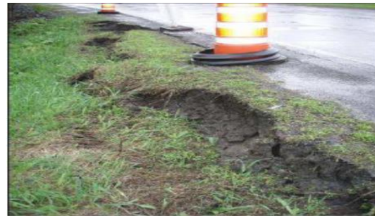
b)- état de l'accotement en 2011
