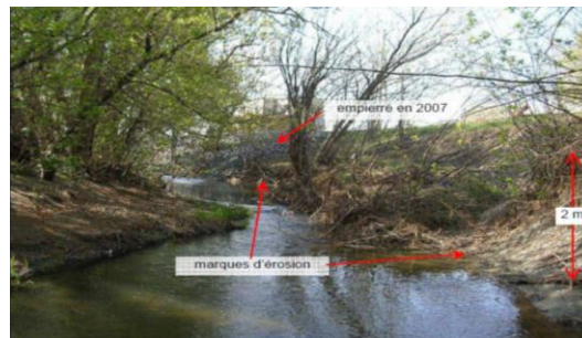
Fig. 4. Empiètement des débris dans la rivière Saint-Jacques. Marques importantes d'érosion à l'avant-plan et empierrement à l'arrière plan.
