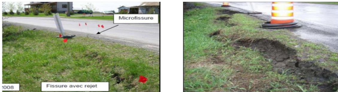
a)- état de l'accotement en 2008
